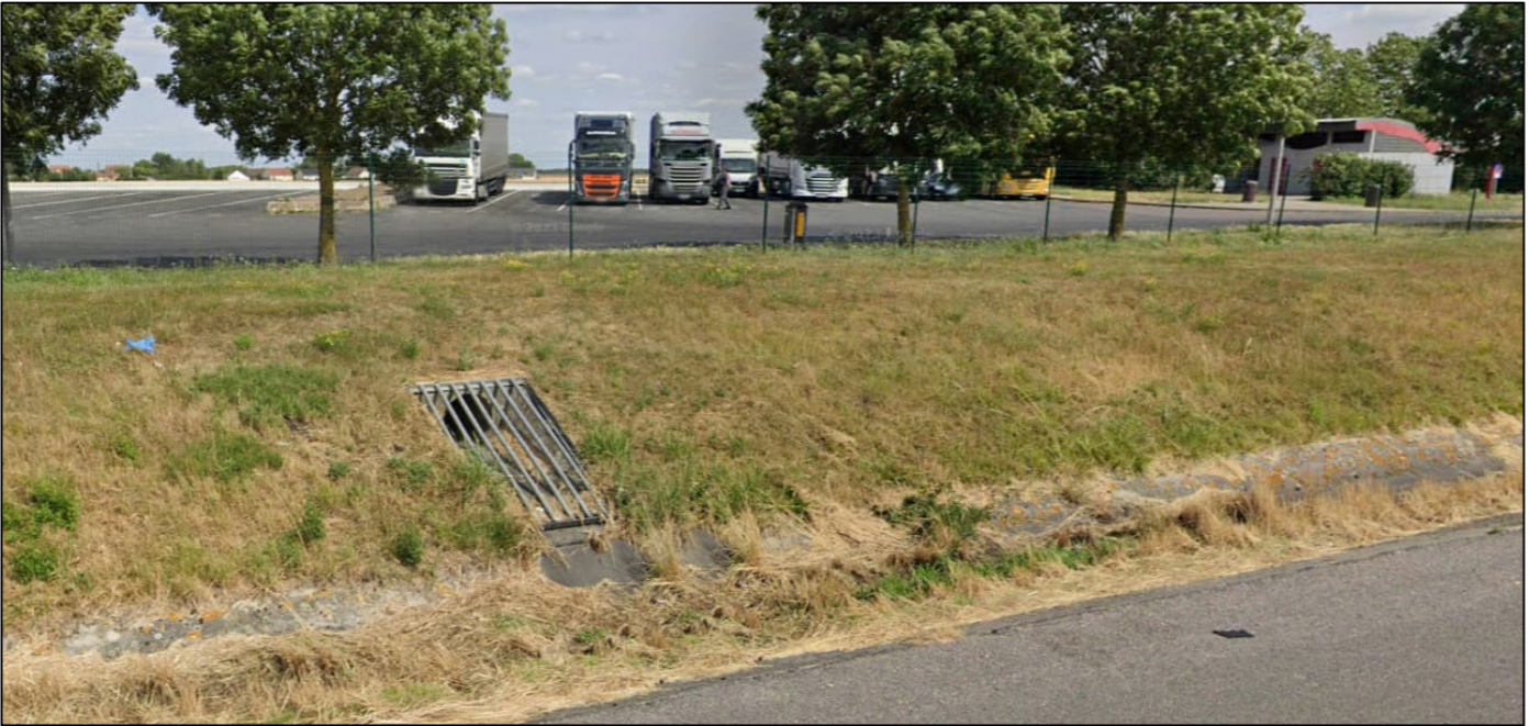
Exutoire principale vers la cunette en béton de la RN154
